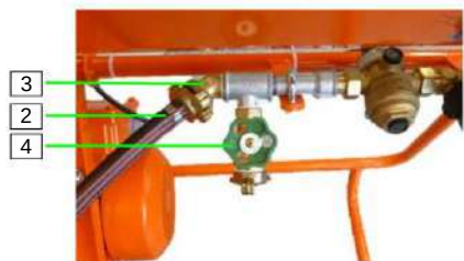
Figura 22: Conexão do abastecimento de água
